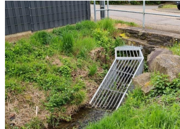
Einlaufbauwerk Auf'm Mühlenspitz (Heimbach-Weis)
