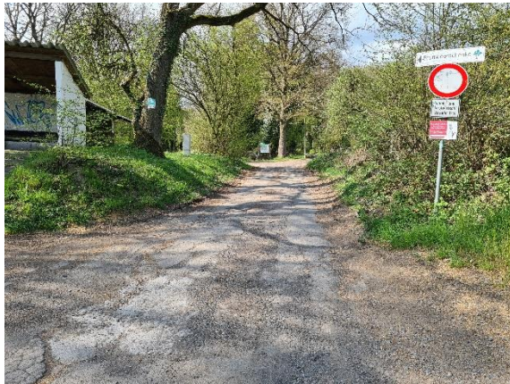
Kreuzungsbereich Höhenstraße/Neuer Weg
