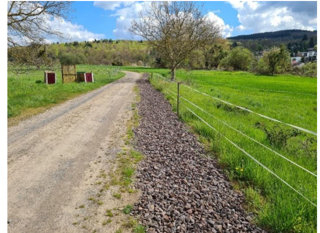
Straßenbegleitende Rigolen in Oberbieber, Quelle: BCE
